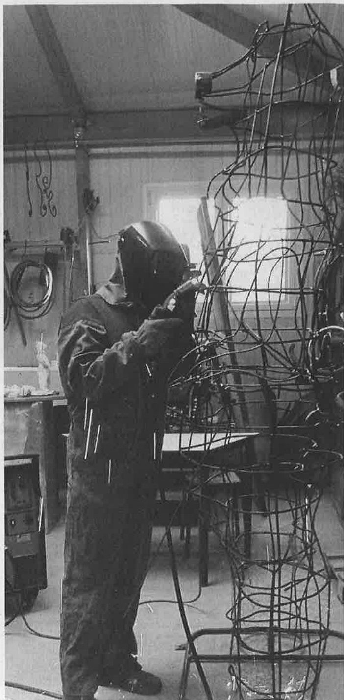
Les travaux ont démarré par la soudure de la structure
